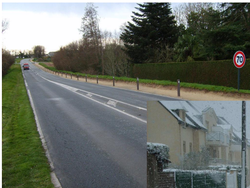
Aménagement de sécurité des piétons route Ploubalay Lancieux
