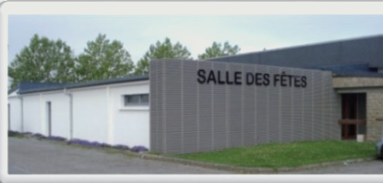
Installation d'un bardage sur la façade de la salle des fêtes
