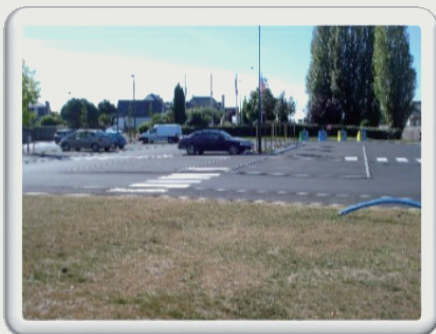
Démolition de l'ancienne gare et aménagement du parking
