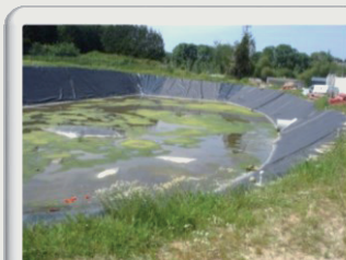
Bassin d'orage à la station d'épuration
