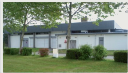
Peinture des murs de la salle des fêtes
