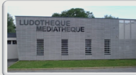
Installation de la signalétique
