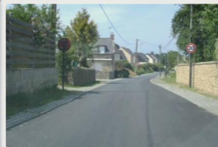
Enrobé de la rue des Basses Sautrais après travaux d'assainissement
