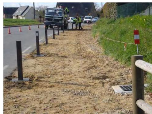
Dans le cadre du programme pluriannuel de réfection du réseau des eaux usées de Ploubalay, les travaux ont débuté en Janvier 2012. Deux techniques sont utilisées. Quand l'état de la conduite le permet on injecte un produit qui vient en « chemiser » l'intérieur, évitant ainsi l'ouverture de la chaussée et le remplacement du tronçon. Quand la détérioration est trop avancée, on procède au remplacement du tronçon.
